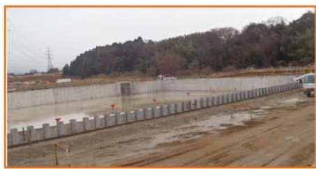
2号調整池(その1)及び17期排水路【完了】 7期区画道路
