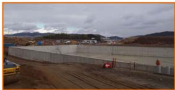
2号調整池(その2)及び20期排水路
