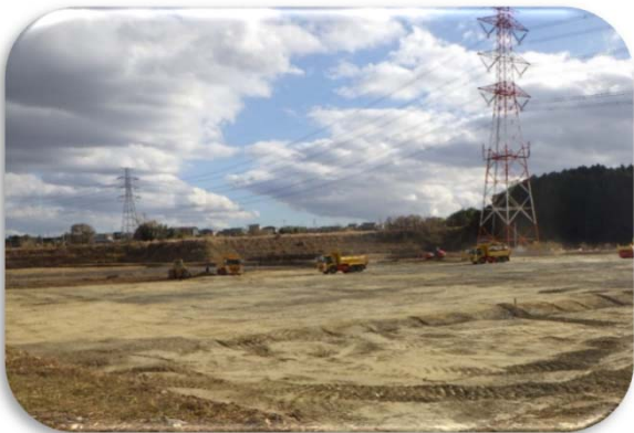
B1ブロック用地Aの状況 (令和元年12月時点)
