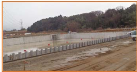
2号調整池(その1)及び17期排水路【完了】
