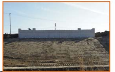
野添川2号橋(下部工)【完了】
